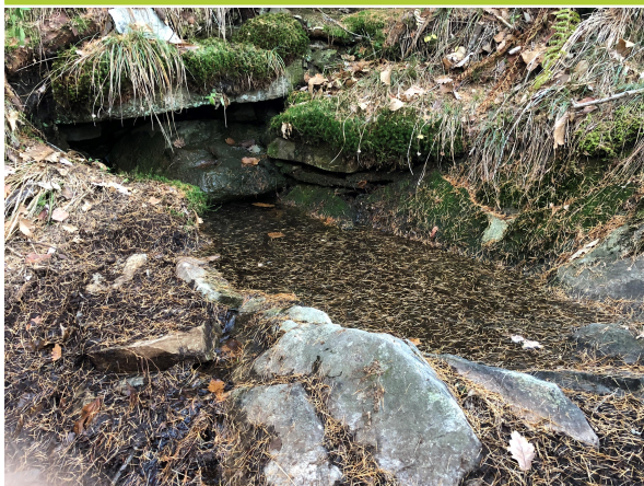
e dopo l'intervento
